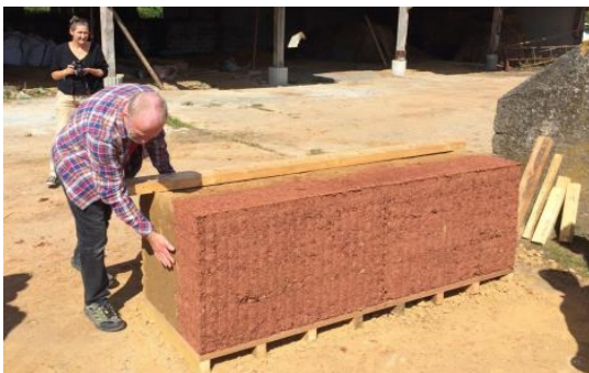
Nouvelle structure du mur en bauge
