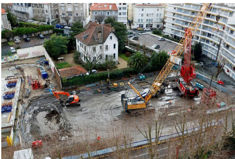
Exemple de chantier où le terrain naturel n'a pas été préparé pour accueillir les machines de forage. Résultat : orniérage du sol et embourbement de la plateforme.
