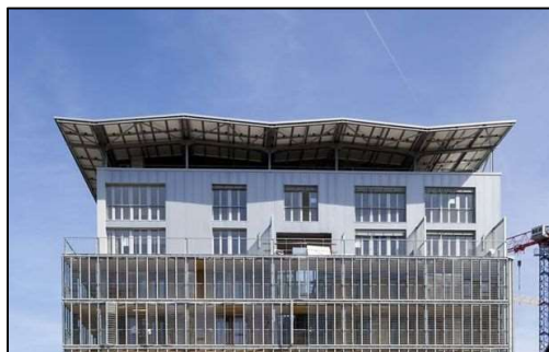
Totalité de la toiture de l'immeuble Amplia recouverte de panneaux photovoltaïques
