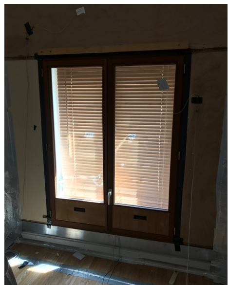
Figure 1 Double fenêtre ventilée, équipée du store vénitien dans le canal.
