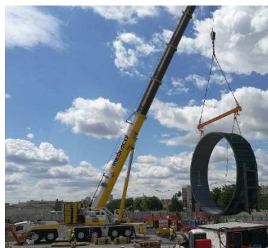
Transfert et montage des cerces
