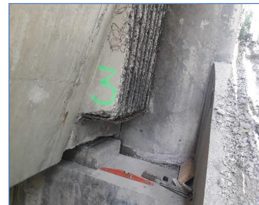
Dégagements des aciers par hydrodémolition pour réparation des zones d'appuis des verins
