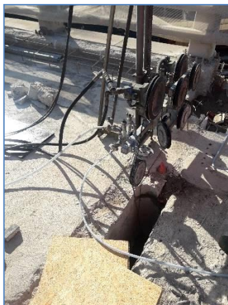
Ouverture des souffles : sciage par câble
