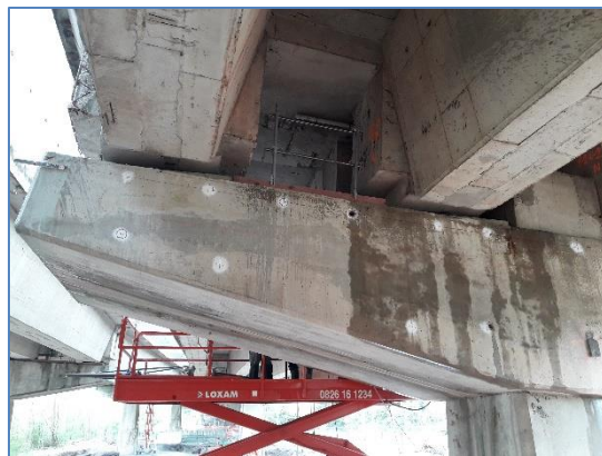
Carottages de précision traversant les chevêtre de piles
