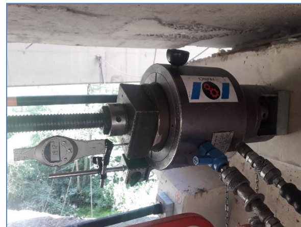
Mise en tension des barres de précontrainte
