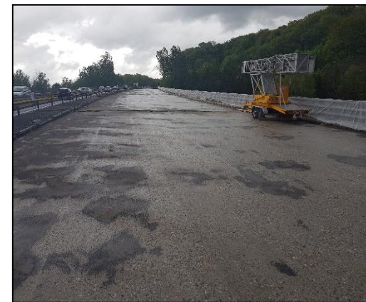
Dépose superstructures
