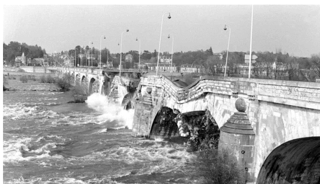
Figure 1-Effondrement du pont Wilson à Tours (Source: La Nouvelle-République)
