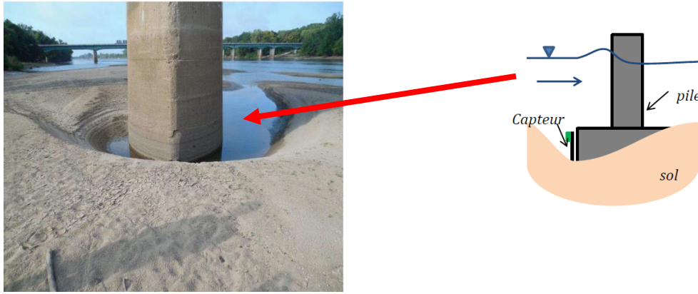
Figure 2-Affouillement au droit d'un appui et développement d'un capteur dynamique.
